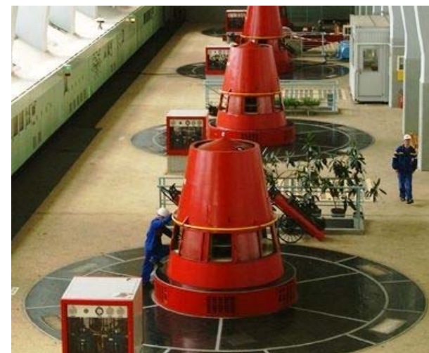
generátory ve strojovně vodní elektrárny Kamýk
