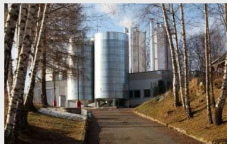
Světlá n. Sázavou Kotelna Bradlo, ul. Na Bradle Instalovaný výkon: 2 036 kW e , 8 454 kW t
