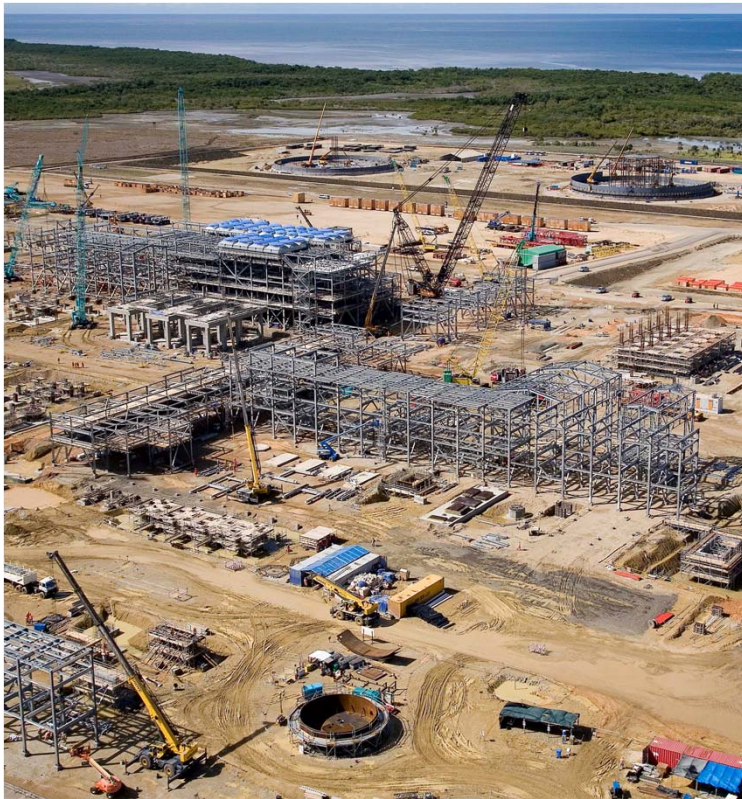
LNG Plant Construction Papua New Guinea
