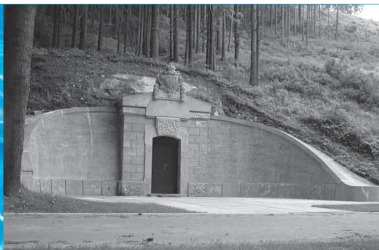
Portál I. březovského vodovodu Portal of 1th water conduit "Březovský"
