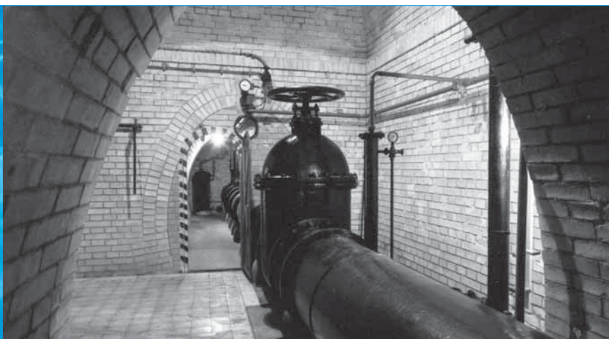
Štola prameniště I. březovského vodovodu
