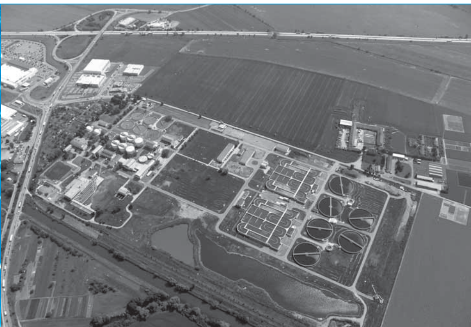
Čistírna odpadních vod Brno - Modřice Brno - Modřice waste water treatment plant
