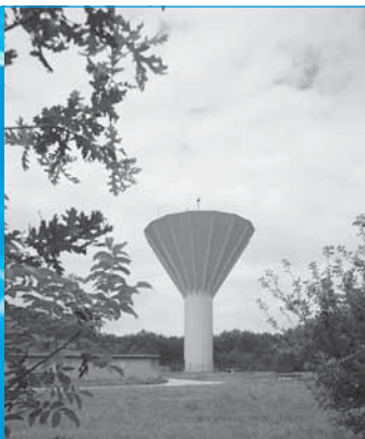
Věžový vodojem Brno - Kohoutovice Tank tower Brno - Kohoutovice
