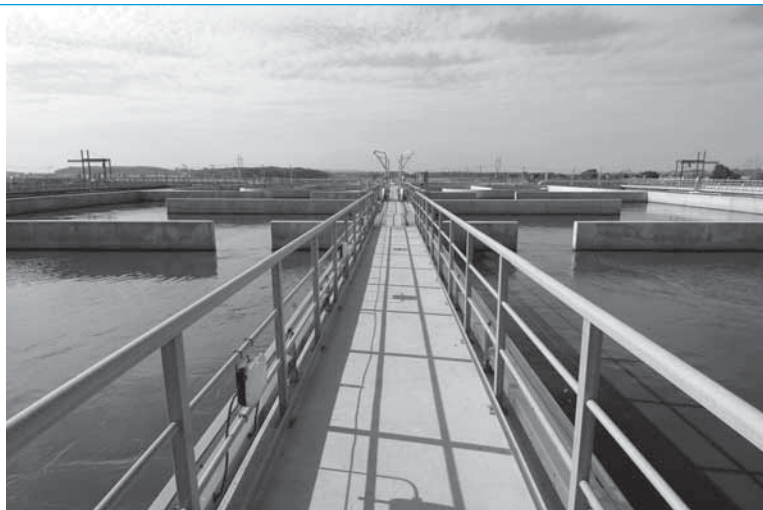
Čistírna odpadních vod Brno - Modřice Brno - Modřice waste water treatment plant
