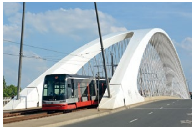
26 Dopravní podnik hlavního města Prahy patří k největším zákazníkům PRE. Elektřina od PRE pohání tramvaje po celé Praze.
