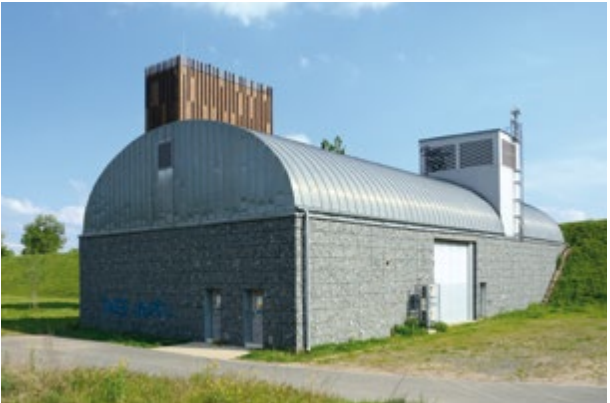
19 Rozpínací stanice u vyústění tunelu Blanka slouží k napájení celého tunelového komplexu.
