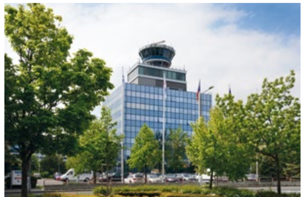
33 Dceřiná společnost PREdistribuce připravuje výstavbu nové rozvodny pro napájení Letiště Václava Havla Praha.
