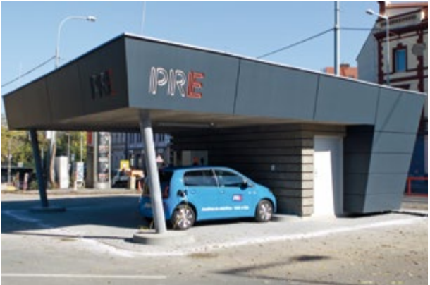
21 Rychlodobíjecí stanice pro elektromobily u holešovického Výstaviště využívá elektřinu z vlastních fotovoltaických panelů a vlastní bateriové úložiště.
