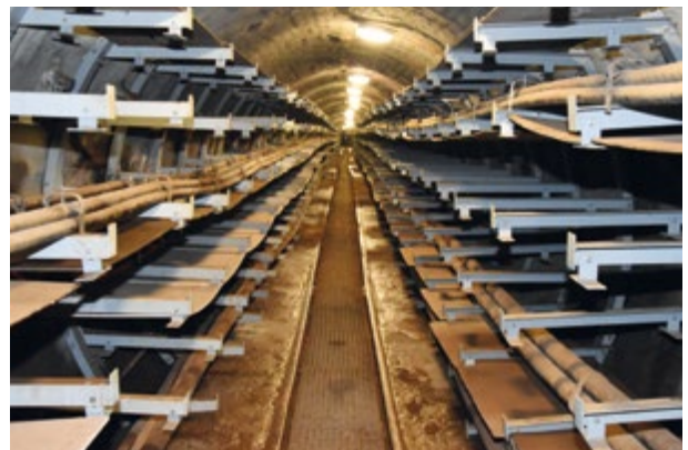
27 Kabelový tunel Holešovice propojuje rozvodny Praha-Sever a Praha-Holešovice a vyvádí výkon z TR 110/22 kV Holešovice do oblastí Praha Holešovice, Bubny a Troja.
