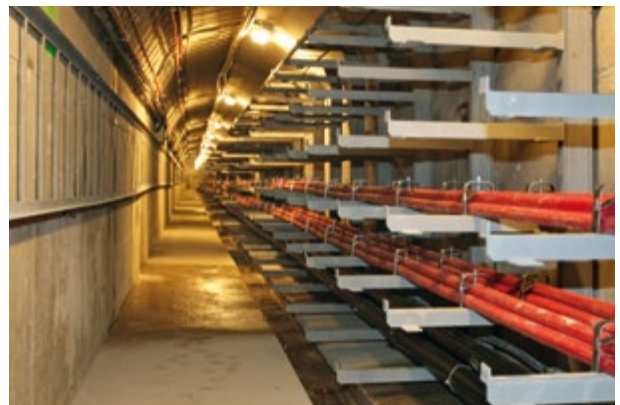
15 Před deseti lety se podařilo kabelovým tunelem propojit oba břehy Vltavy. Část kabelového tunelu mezi rozvodnami Smíchov a Karlov vede přímo pod Vltavou. Je dlouhý téměř dva a půl kilometru a vede v hloubce až dvacet osm metrů.
