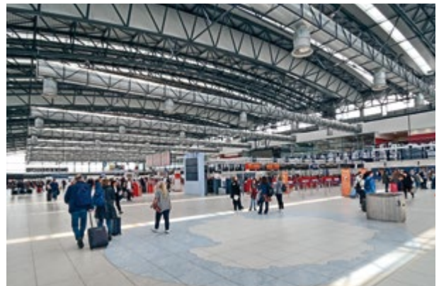
32 Společnost FRONTIER TECHNOLOGIES provedla na terminálu 2 Letiště Václava Havla Praha výměnu konvenčního výbojkového osvětlení za moderní ledková svítidla.
